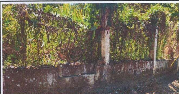
Foto 1: Cambio de base y sustitución de malla
