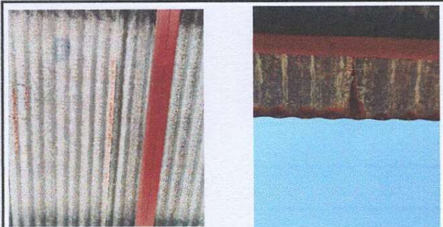
Foto 3: cambio de lamina en bodega y direccion
